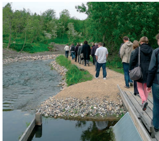
Foto angiver reguleringsbygværket til højre og stryget (nyt vandløb) til venstre. Bygværkets funktion er at regulere en del af vandføringen fra vandløbet ind gennem mølledammene og videre til selve møllen, mens stryget sikrer faunapassagen for fisk og smådyr i vandløbet.
